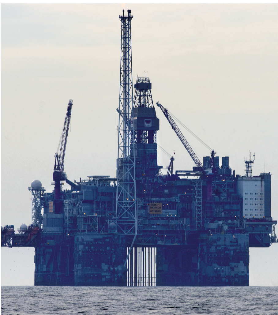
Avtale: Reinertsen AS har blant annet kontrakt på vedlikehold av Heidrunplattformen i Norskehavet. Foto: FRANK CADAMARTERI
